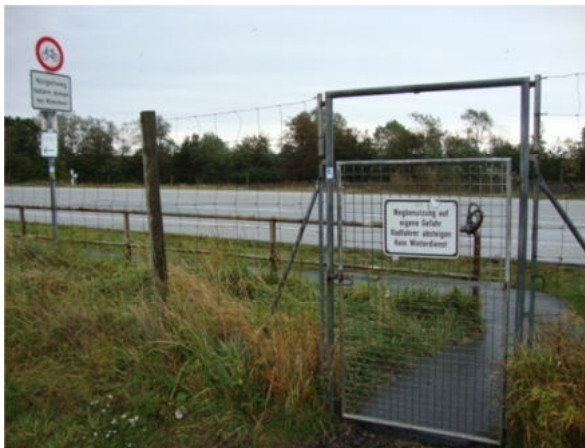
Abbildung 48: Zufahrt Fehmarnsundbrücke Landseite
