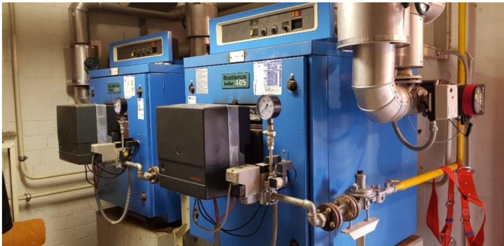
Abbildung 2: Niedertemperatur-Heizkessel in der Redwood-Halle (Baujahr 1985)
