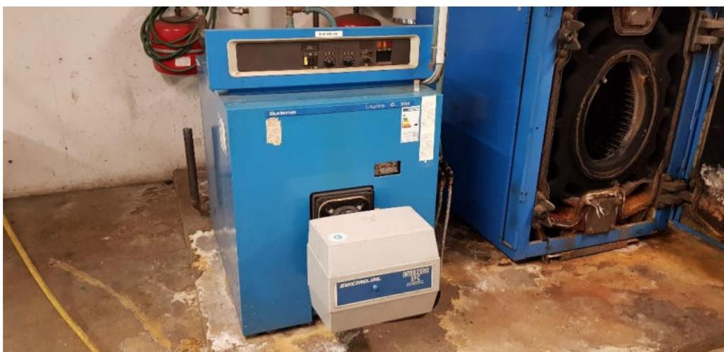
Abbildung 3: Niedertemperatur-Heizkessel in der Blandford-Halle (Baujahre 1985, 1991)
