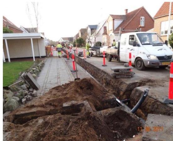
Wärmenetzarbeiten in Løgumgaard (hier Einzelhausbau mit vergleichsweise geringen Grundstücksbreiten).
