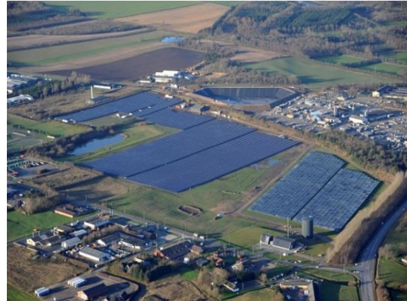
Unten rechts: Neues Verwaltungs- und Betriebsgebäude samt Pufferspeicher und 1. Ausbaustufe Solarthermie (17.500 m 2 ) Bild Mitte: 2. Ausbaustufe Solarthermie (54.000 m 2 ) Oben Mitte: Erdbeckenwärmespeicher (200.000 m 3 )
