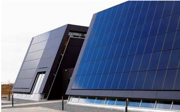
Die neue Zentrale entspricht architektonisch der in Graasten
