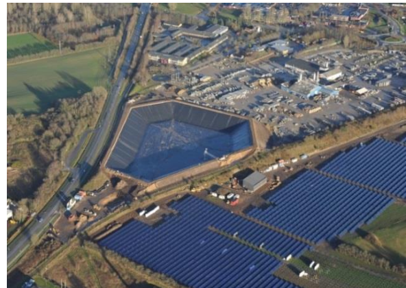
Bild Mitte: Erdbeckenwärmespeicher im Bau (Foto 9.12.2014)
